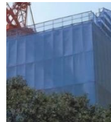
工事用 仮設シート
