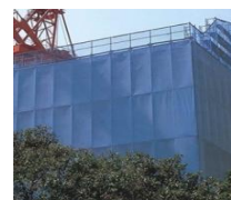
工事用 仮設シート
