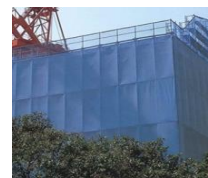
工事用 仮設シート
