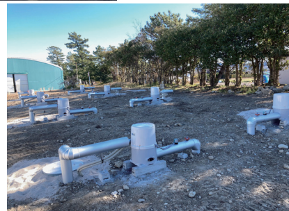
左上:ヒートポンプシステム部分 右下:水を汲み上げ地下水の熱エネルギーを利用 出所:会社資料
